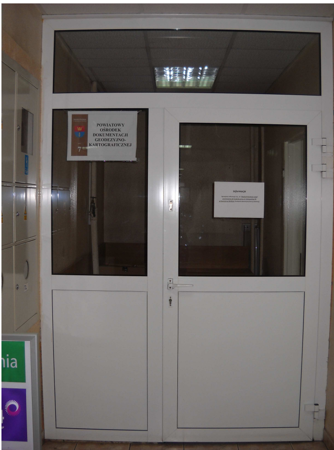
Fot. 3. Drzwi wejściowe z korytarza do pom. socjalnego nr 5 do oklejenia folią matową
