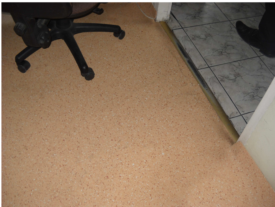
Fot.10. Istniejące linoleum do demontażu w pom nr 6.
