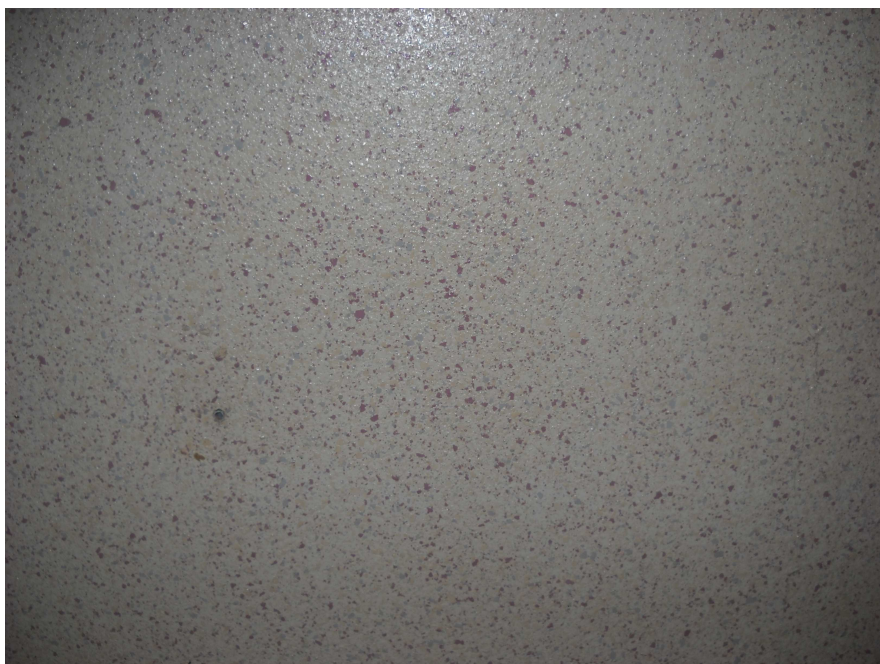
Fot. 8. Kolor ściany na korytarzu
