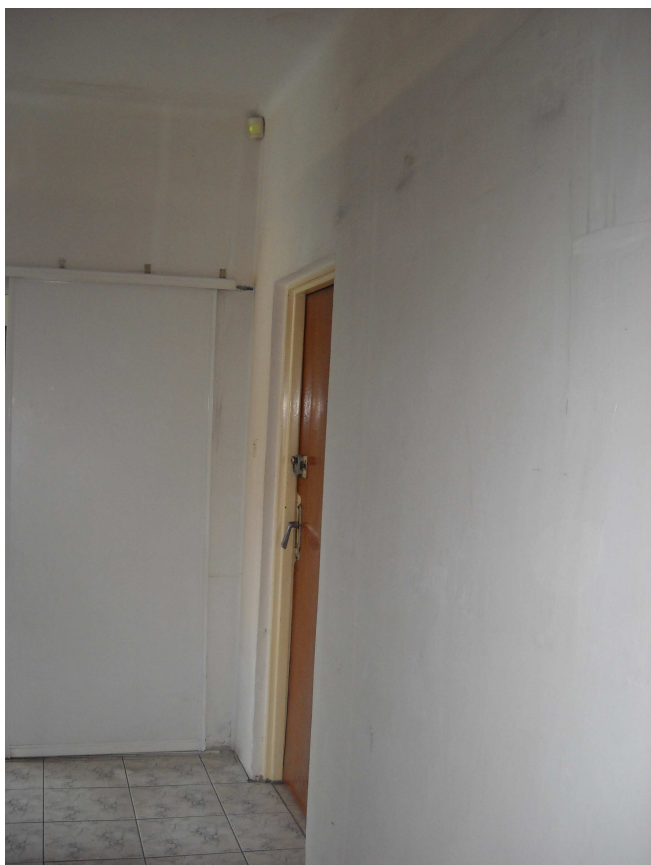
Fot.12. Istniejące drzwi w pom. nr 8 do demontażu
