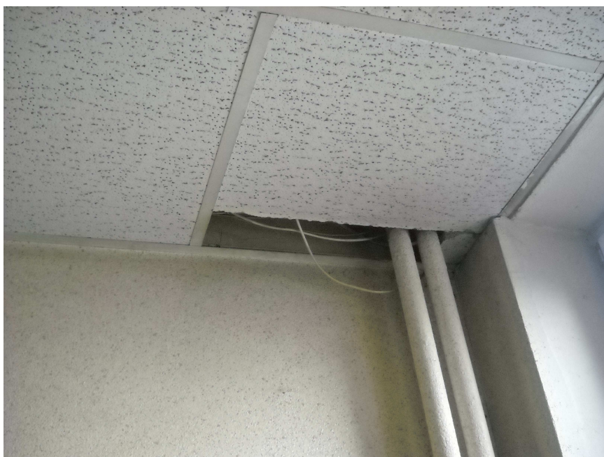
Fot. 13. Istniejące kasetony na aluminiowym ruszcie na korytarzu
