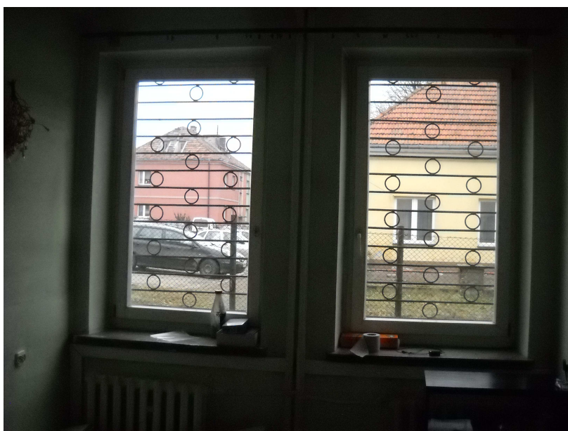
Fot. 5 Grzejniki z pionami oraz zewnętrzne kraty w oknach do malowania
